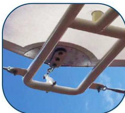
Piastre triangolari ad angoli arrotondati in acciaio inox e grilli e golfari per ancoraggio e tensionamento.
