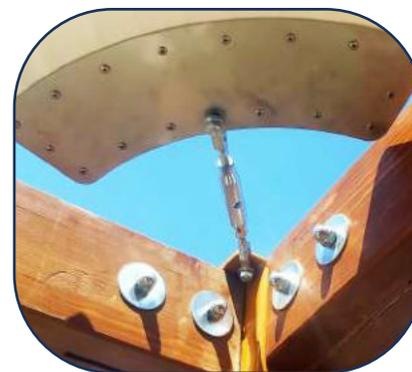
Piastra a mezzaluna, tenditore e bullonerie in acciaio fissate alla struttura in legno
